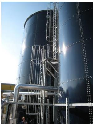
Kernstück der betrieblichen Abwasserreinigungsanlage ist der Membranbioreaktor mit externen cross-flow Membranen.
