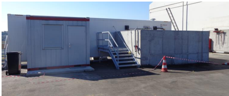
Abbildung 2 Laborcontainer und Biologiebecken (im Vordergrund) und dahinter der 40“-Anlagencontainer
