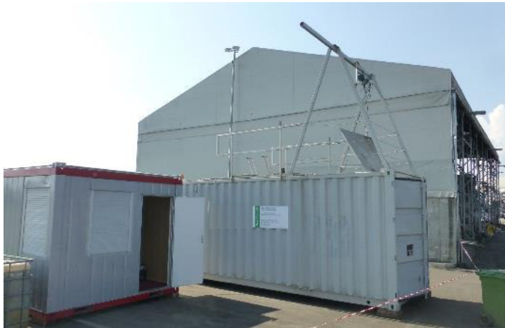
Abbildung 1 MBR-Versuchsanlage im 20“ Container
