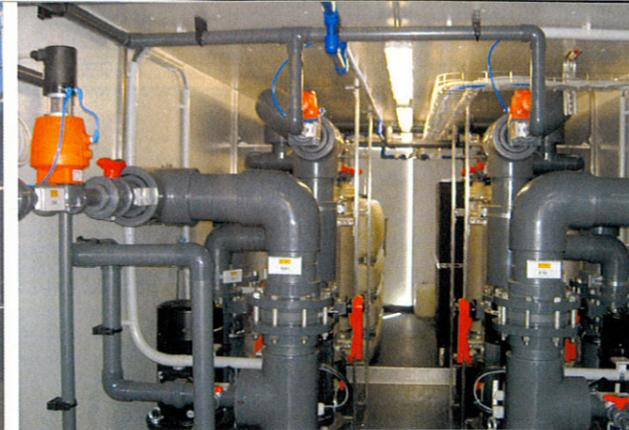
Foto 1: Ultrafiltrationsanlage in Containerbauweise
